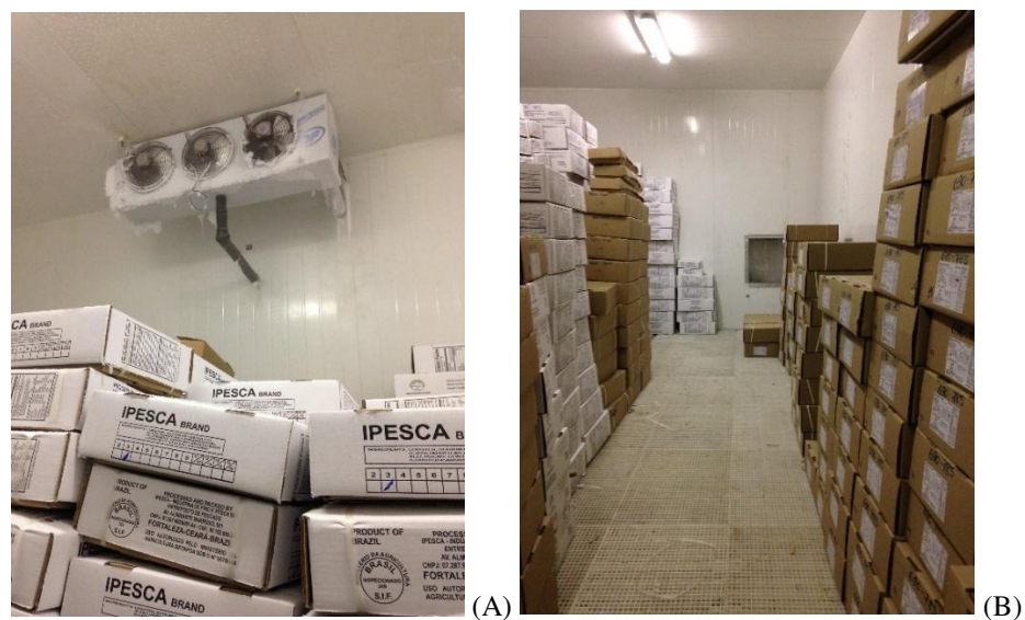
Figura 15 – Sistema de refrigeração (A) e óculo para expedição da câmara de estocagem (B).
