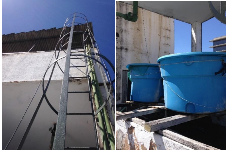
Figura 24 – Bomba dosadora de cloro localizada no segundo andar externo do prédio conectada a tanques com água do poço.
