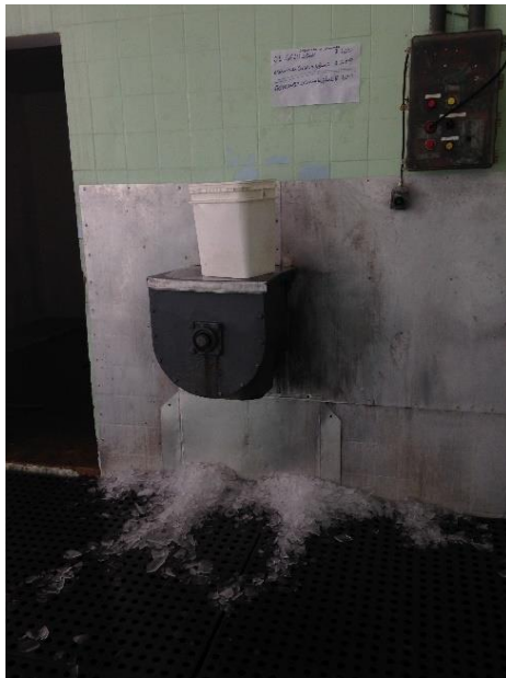
Figura 22 – Saídas do silo de gelo na empresa IPESCA: (A) Plataforma de recepção. (B) Salão de beneficiamento.
