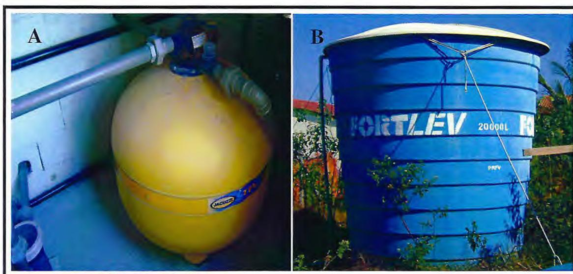
Figura 6 – Sistema de pré-tratamento da água. (A) Filtro de areia que realiza a filtração mecânica da água captada no estuário. (B) Reservatório de estocagem (20.000L) da água pré-tratada que abastece o laboratório.
