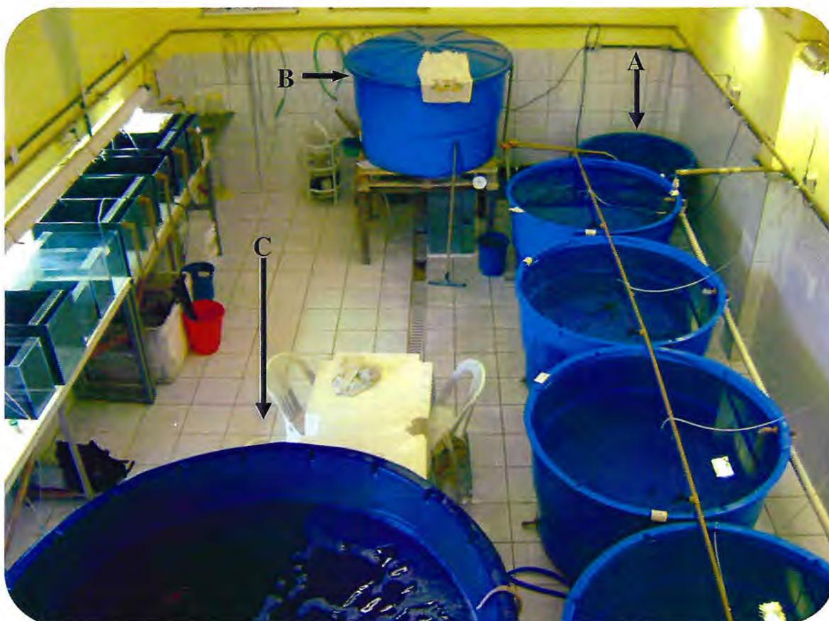
Figura 7 - Sala de Larvicultura. (A) Caixa coletora de 500L. (B) Caixa de reposição de 1000L que abastece o sistema por gravidade. (C) Tanque de 3000L utilizado para armazenar água tratada e abastecer o sistema.
