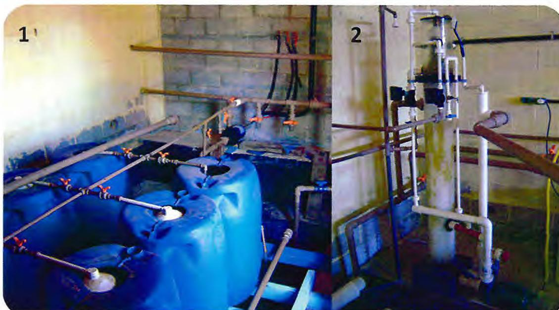
Figura 5 – Sistemas de filtragem. (1) Sistema de Filtragem Biológica composto por “boróias” (rochas colonizadas com bactérias nitrificantes). (2) Protein Skimmer - Filtro mecânico (a nível molecular) que retira poluentes da água pelo fracionamento das proteínas.
