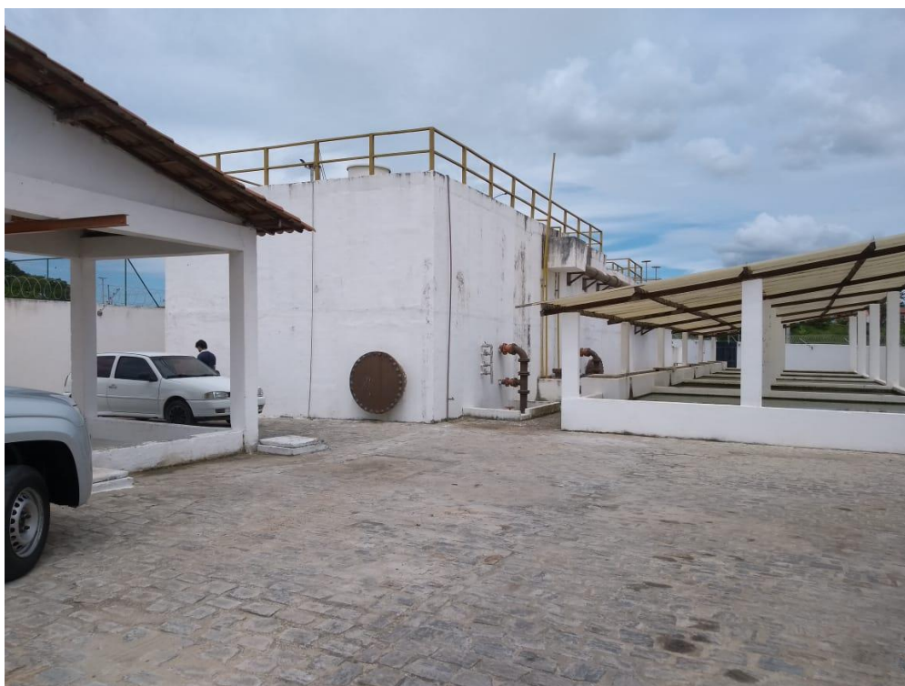
Figura 4 - Vista da entrada da Estação José Euclides
