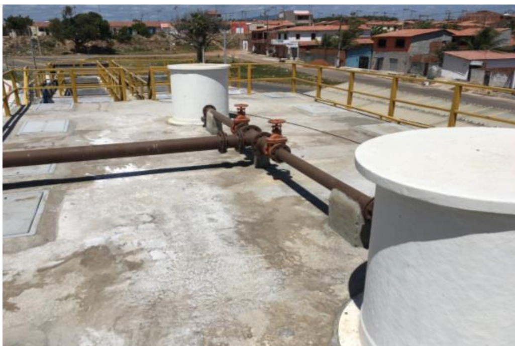
Figura 7 - Visão do pavimento superior dos reatores UASB
