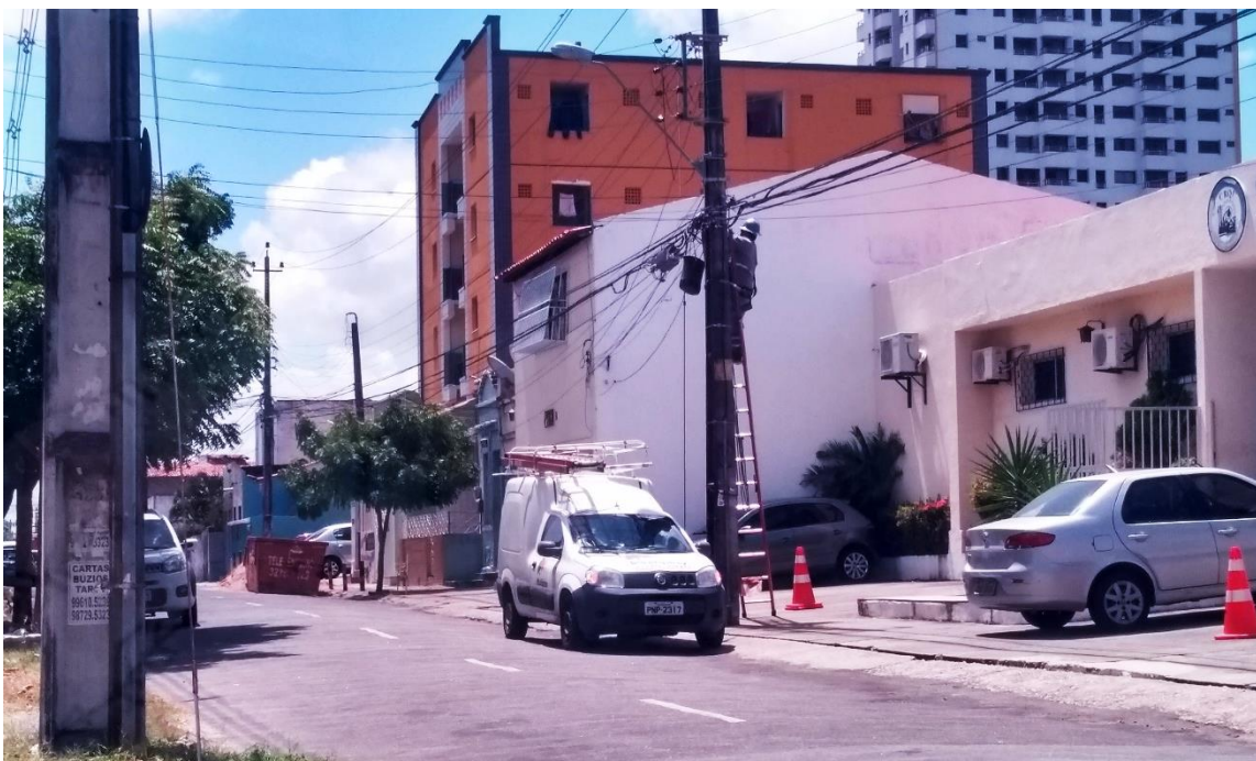
Figura 26 - Manutenção da rede aérea de telecomunicações.
