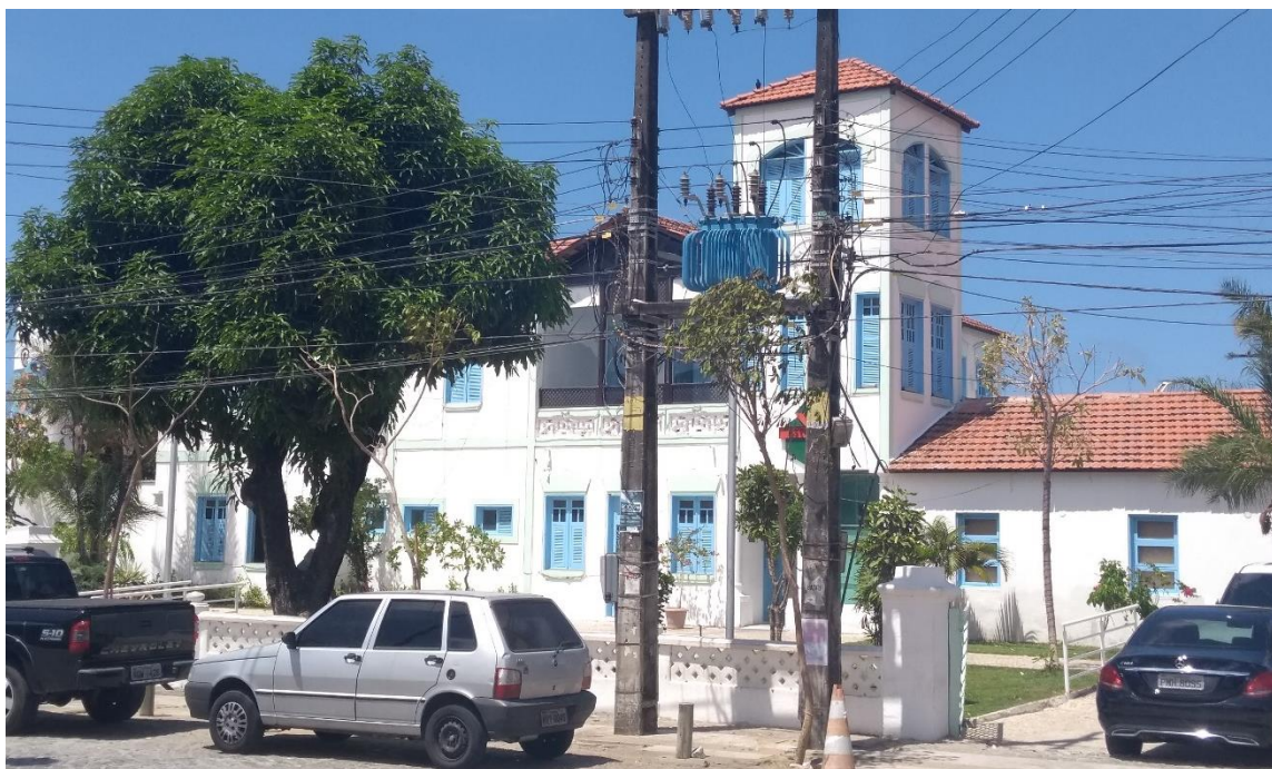
Figura 21 - Infraestrutura de fiação aérea prejudicando a visibilidade do Estorial, bem tombado e patrimônio cultural de Fortaleza.
