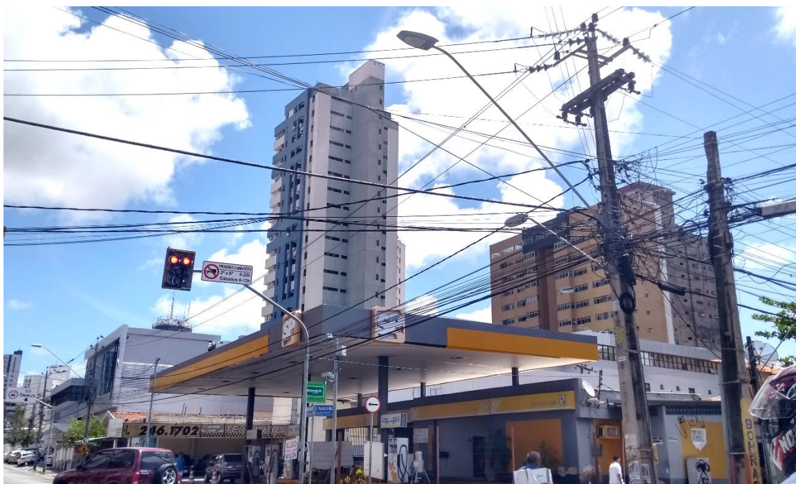
Figura 20 - Infraestrutura de fiação aérea degradando a paisagem urbana.
