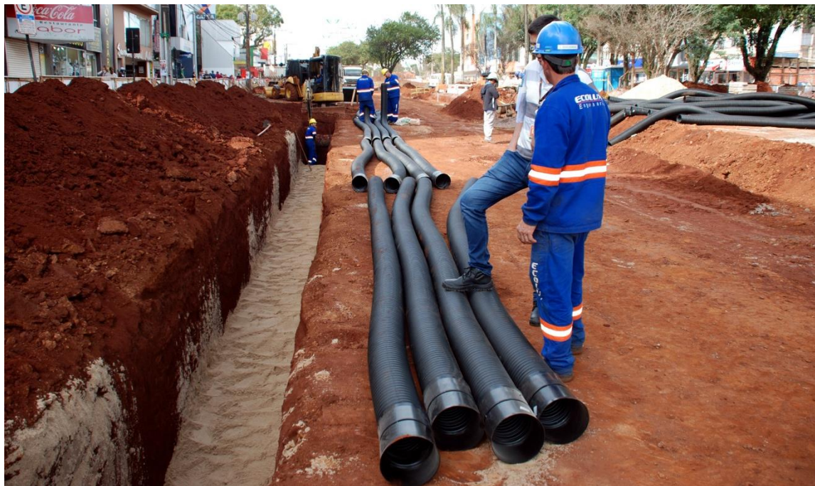
Figura 7 - Implantação da rede de distribuição subterrânea em Cascavel, Paraná.
