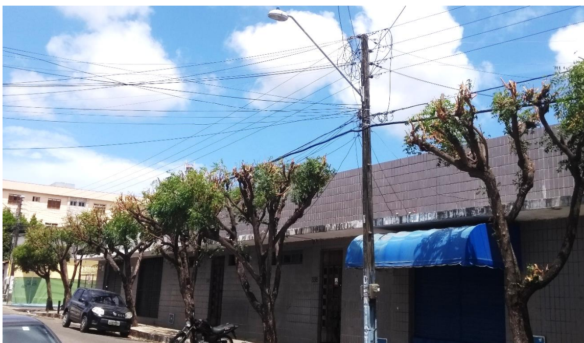
Figura 24 - Fiação aérea impedindo crescimento natural da arborização.
