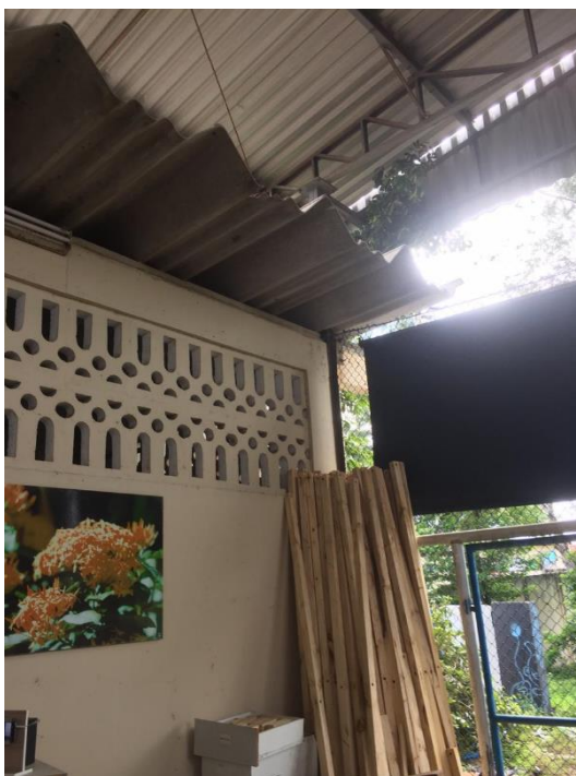
Figura 76 – Parede de alvenaria do Depósito.
