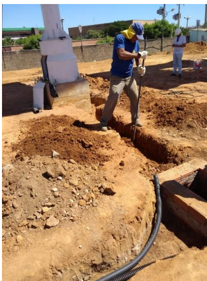
Figura 35 - Escavações para instalações elétricas.
