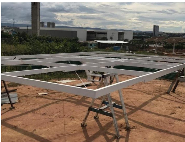
Figura 30 - Grade após pintura.
