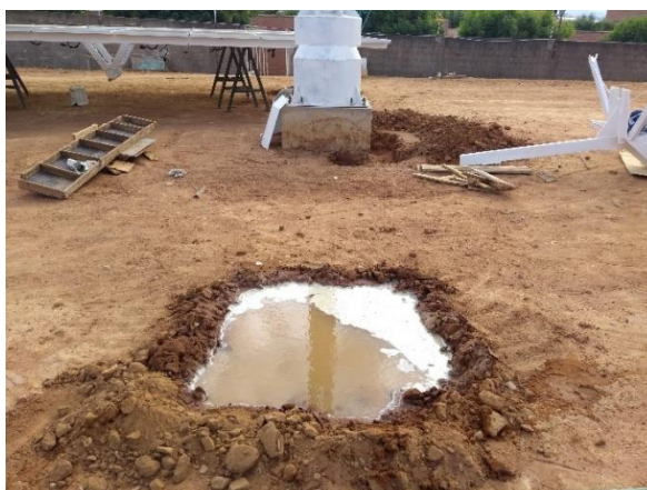
Figura 36 - Detalhe de escavação para caixa de passagem.
