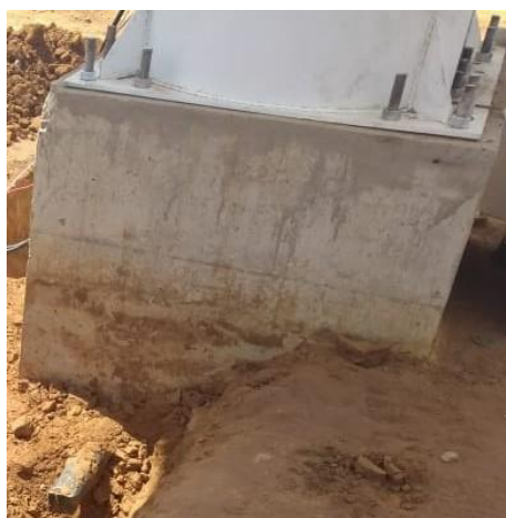
Figura 34 - Detalhe do eletroduto instalado na base de concreto.
