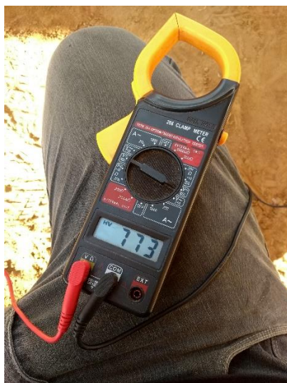
Figura 45 - Medição da tensão de string utilizando multímetro.
