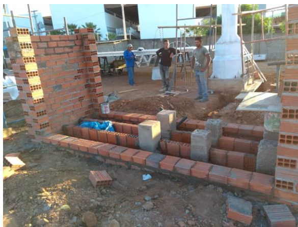
Figura 38 - Construção do abrigo.
