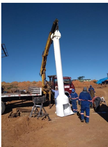
Figura 33 - Caminhão “munck” suspendendo o tronco de um gerador.
