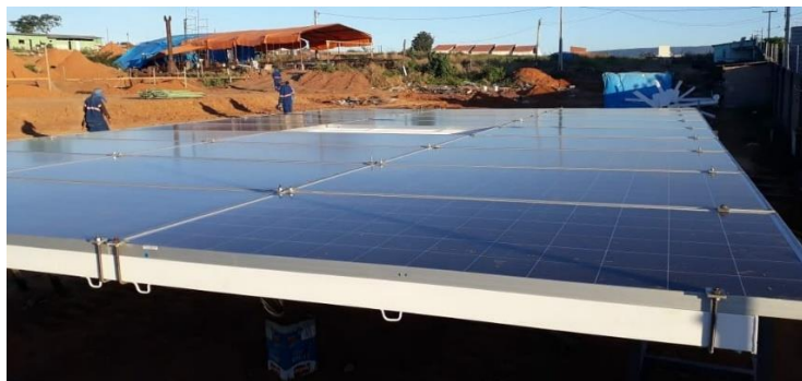
Figura 44 - Módulos FV fixados na grade.
