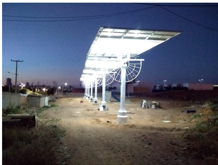
Figura 50 - Teste de iluminação indireta dos geradores.
