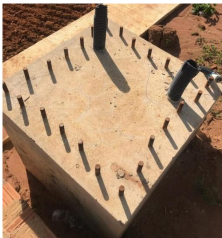
Figura 32 - Detalhe da face superior da base de concreto.
