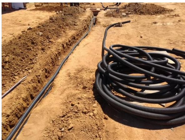
Figura 39 - Instalação de eletrodutos.
