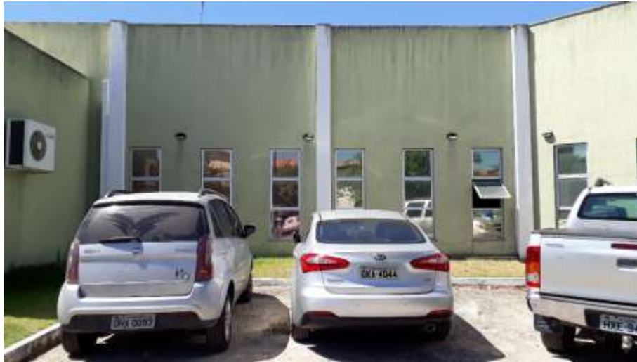
Figura 24 – Detalhe de aberturas na fachada Oeste
