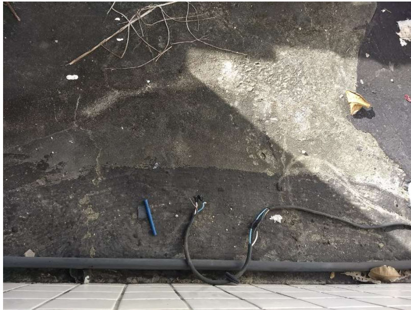
Figura B11 - Registro Fotográfico na Sacada do Pavimento Superior
