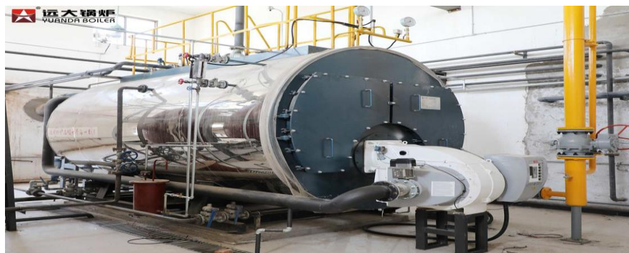
Figura 12 - Caldeira Industrial para Extração de Óleo Essencial.
