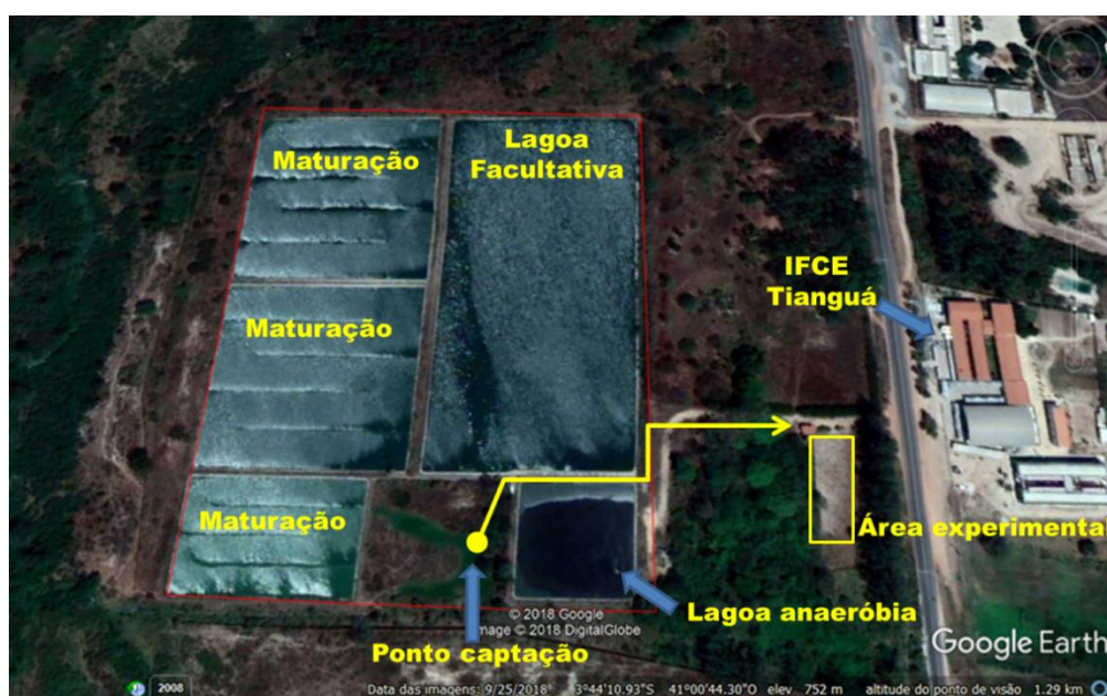
Figura 5 - Estação de Tratamento de Esgoto de Tianguá (ETE Tianguá) e a área experimental
