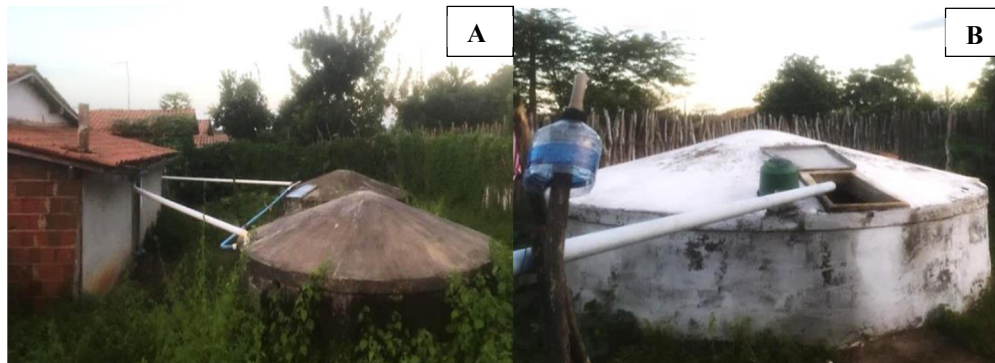
Figura 5 - Cisternas de placas do ACG (4A e 4B).
