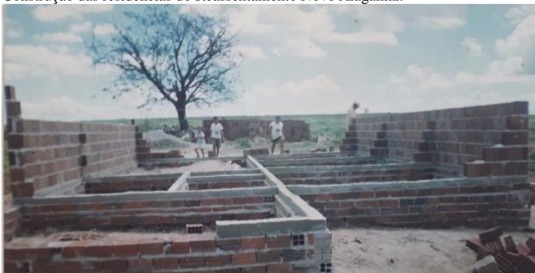
Construção das residências do Reassentamento Novo Alagamar.
