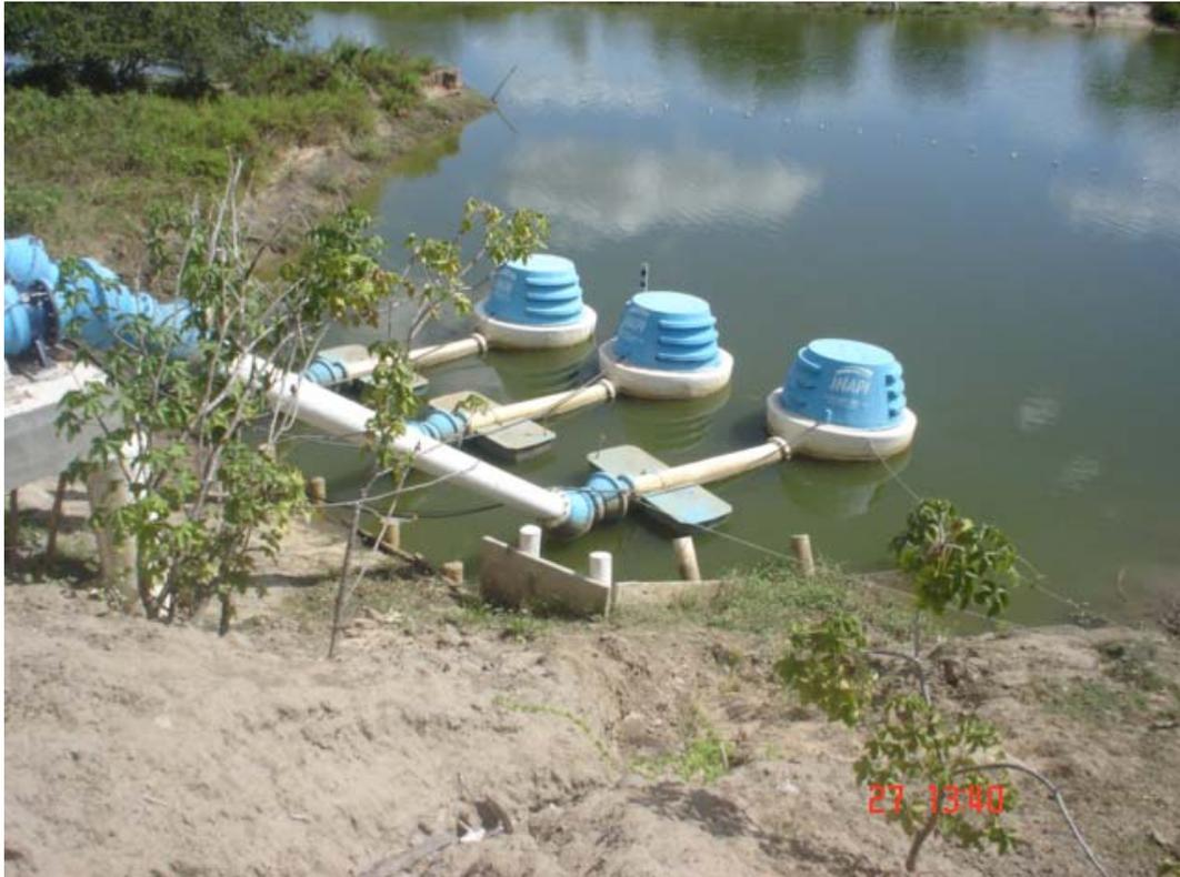
Figura 3.13 - Canal de abastecimento com utilização de bombas flutuantes para captação
