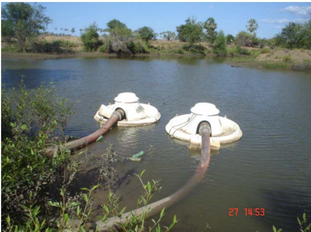
Figura 3.14 - Canal de abastecimento com utilização de bombas flutuantes para captação
