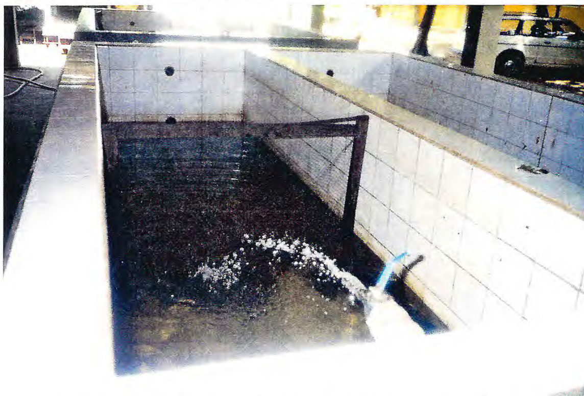
Figura 4 - Tanque de manuseio, vendo-se o sistema de abastecimento através de cano de PVC e torneira de registro.
