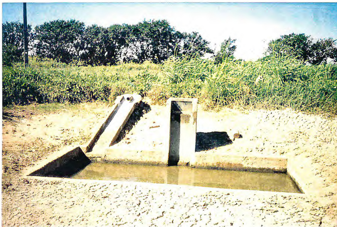
Figura 3 - Monge, caixa de coleta e cano de abastecimento.
