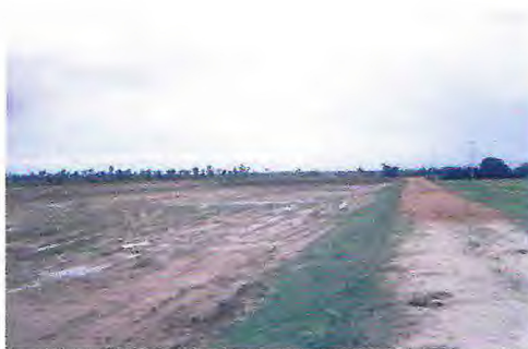
Figura 10 - Aspecto do viveiro com os diques construídos, porém com necessidade de regularização normal do piso
