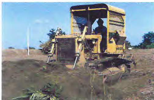
Figura 6 - Máquina trabalhando na movimentação de terra de expurgo
