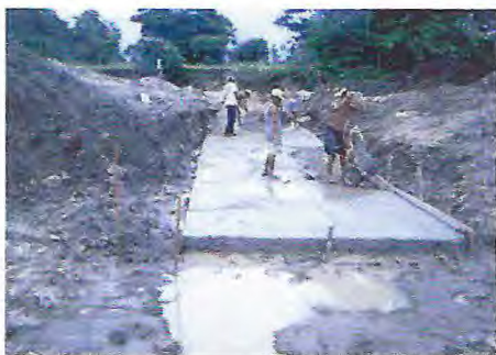
Figura 21 - Laje de fundo do sistema de drenagem
