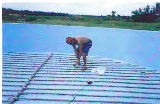
Figura 31 - Detalhe da colocação da tubulação distribuidora de ar.
