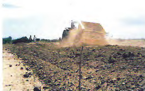
Figura 8 – Levantamento dos diques, observando-se a deposição do material de escavação nos taludes.
