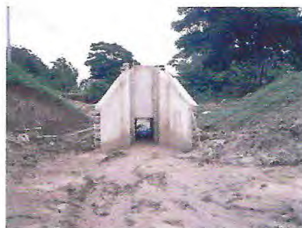
Figura 22 - Sistema de drenagem completado sem aterro
