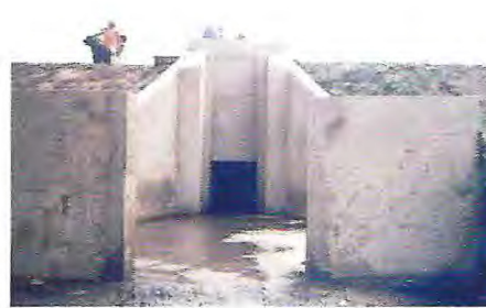
Figura 24 - Visão de trás do sistema de drenagem concluído.
