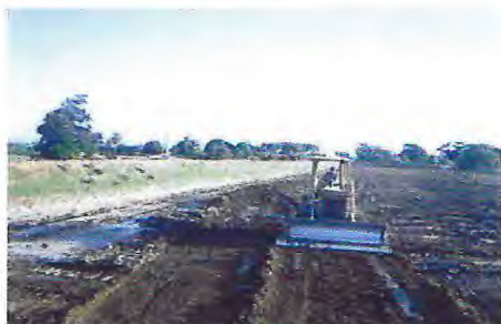
Figura 11 – Nivelamento do viveiro
