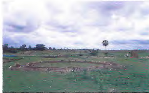
Figura 30 - fundação para a construção do tanque berçário.
