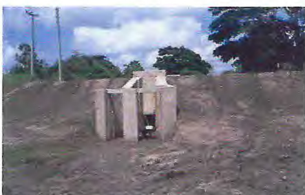
Figura 23 - Sistema de drenagem completado com aterro.
