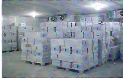
Figura 9. Câmara de estocagem de produto final.
