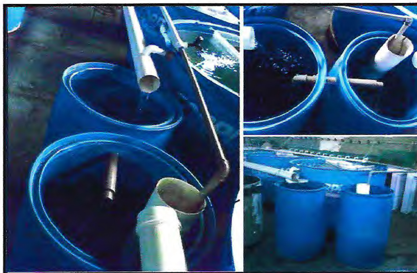
FIGURA 2-Módulo de filtragem (mecânica e biológica).
