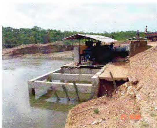
Figura 4 – Motobobas de absatecimento de água do aflente a esquerda. Saída de água dos motorbobas para os afluentes a direita da Fazenda Aquacultura Fortaleza, Camocim - CE .
