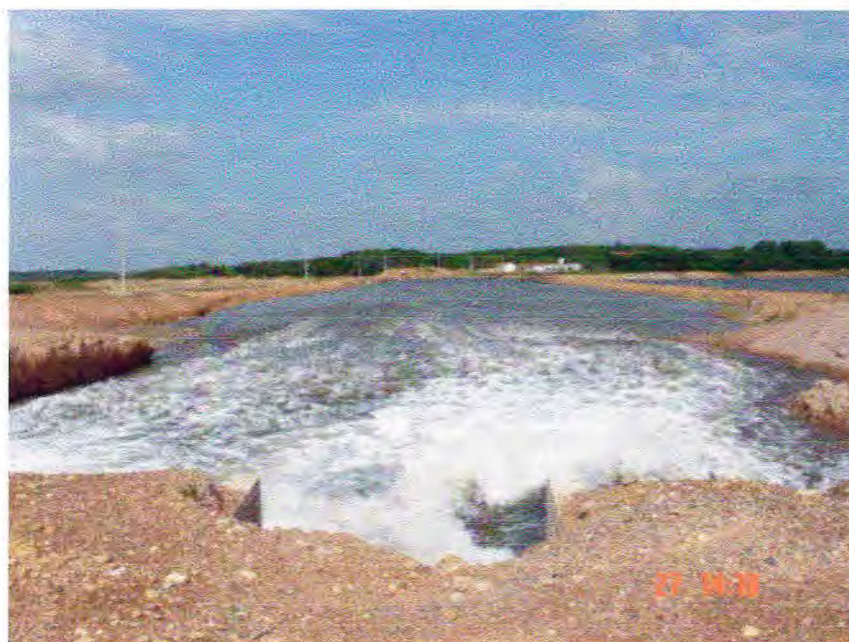
Figura 3 – Canal de Abastecimento da Fazenda Aquacultura Fortaleza AQUAFORT S.A. Camocim – CE.
