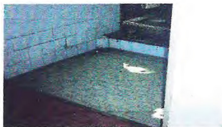
Figura 27. Pedilúvio com água clorada na entrada do salão de beneficiamento
