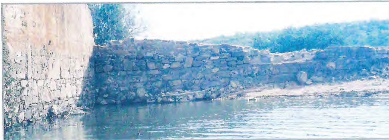
FIGURA 9 - Área de sangradouro do açude Marengo em 21/02/05.
