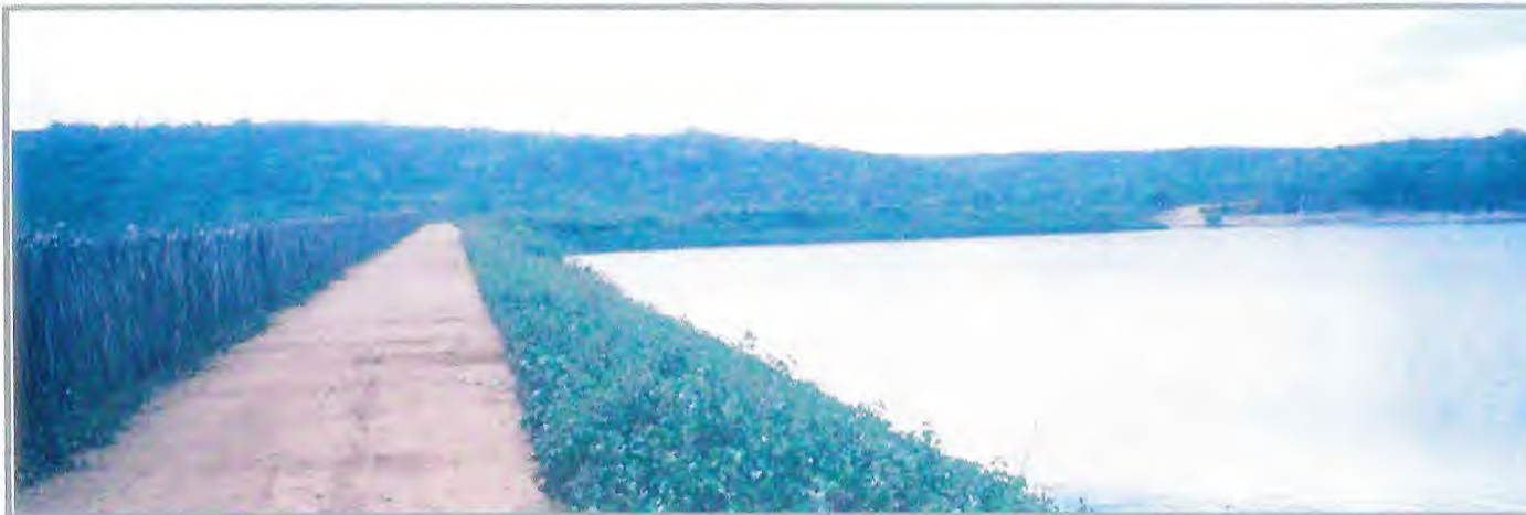
FIGURA 7 - Vista parcial da barragem de terra do açude Marengo em 21/02/05.
