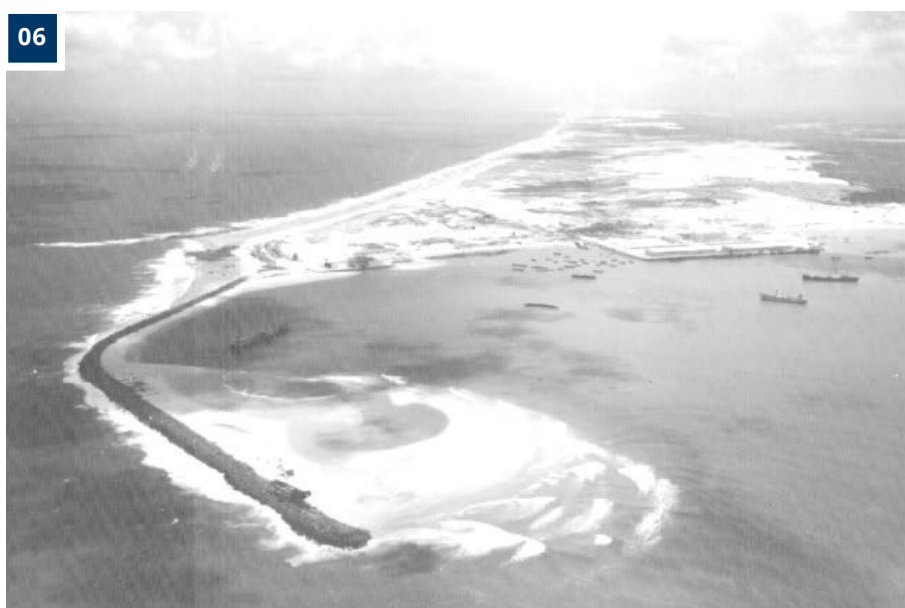
Figura 06 Construção do Porto do Mucuripe, Espição e à esquerda, a Praia do Futuro ainda deserta Fonte: Arquivo Nirez
