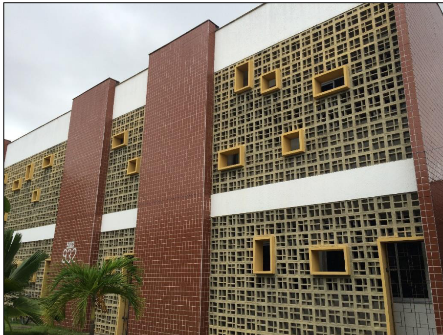
Figura 3 – Fachada do Bloco.
