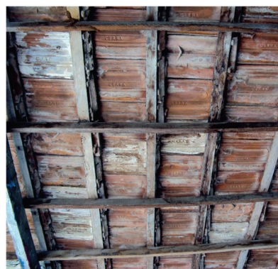
Coberta varanda Telha marselha
