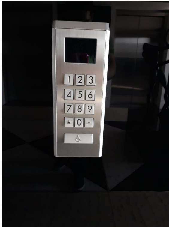
Figura 15 - Painel externo dos elevadores inteligentes.
