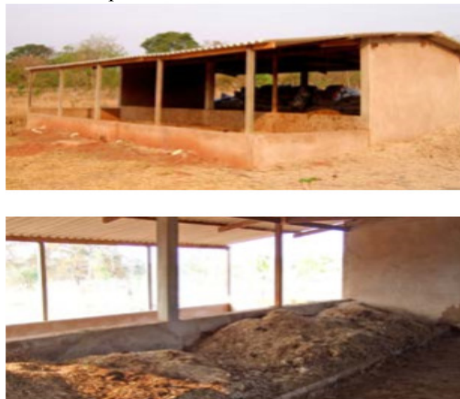
Figura 15 - Composteira construída em alvenaria
