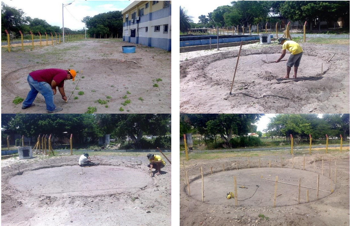
Figura 11 – Demarcação, escavação e nivelamento da base do primeiro módulo.
