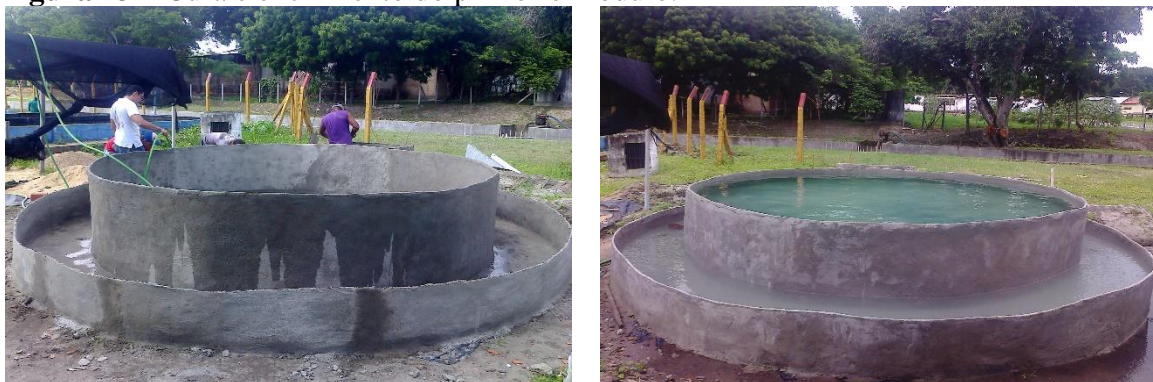
Figura 13 – Cura e enchimento do primeiro módulo.
