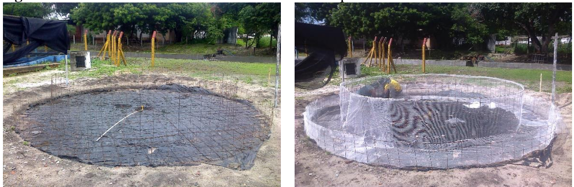
Figura 12 – União da malha de ferro com a malha de polietileno.
