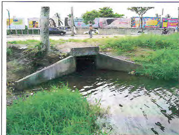
Figura 12 Comporta de drenagem da lagoa- Lado norte.
