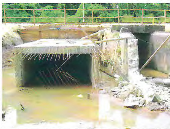
Figura 11 - Construção de galeria para passagem de água por baixo da linha do trem e vai despejar direto para lagoa.
