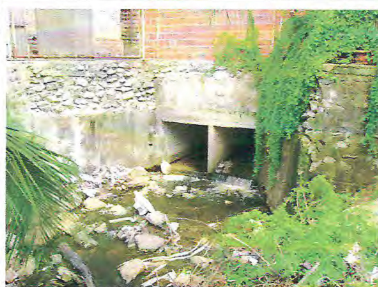
Figura 13. Galeria de passagem da água e continuação do riacho Maraponga.
