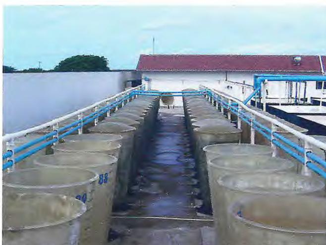
Figura 18. Tanques cilíndricos de 500 litros utilizados na etapa intermediária do cultivo massivo de microalgas no laboratório de pós-larvas da empresa Compescal - Comércio de Pescado Aracatiense Ltda, em Aracati-CE.
