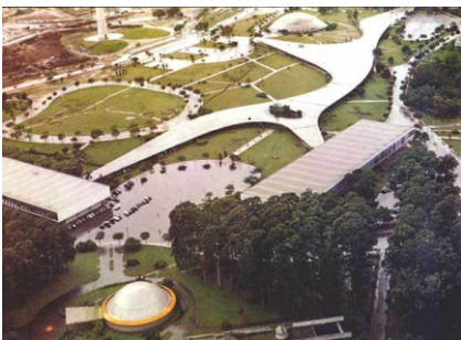
Fig.18.Detalhe Marquise de Concreto Fonte: Google.com
