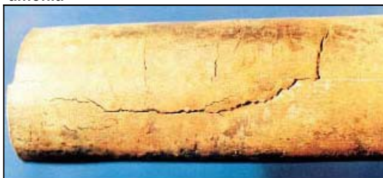
Figura 6 - Tubo de latão que sofreu processo de corrosão por tensão fraturante, após contato com amônia
