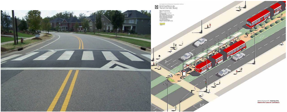
FIGURA 43 (à esquerda): Medidas simples e baratas de traffic calming, como a lombada, podem ser utilizadas para diminuir a velocidade dos veículos e preferenciar o pedestre. FONTE: http://www.blumenews.com.br Acesso em: jan, 2014.
