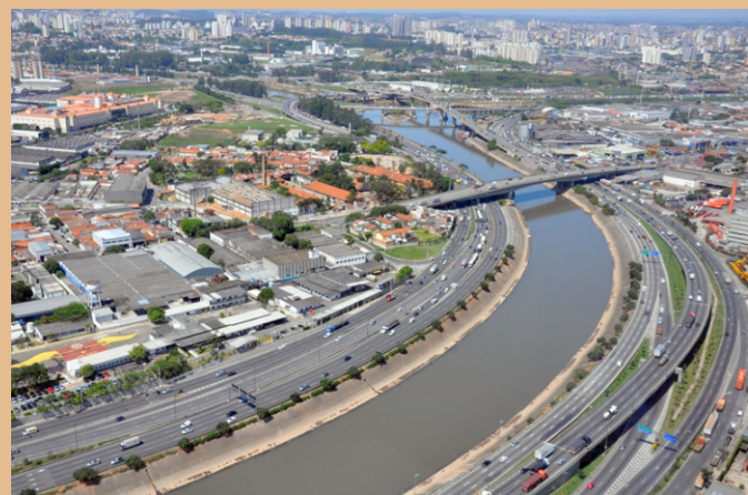
FIGURA 25: Entorno do Ponte dos Remédios Fonte: http://www.hf.arq.br
