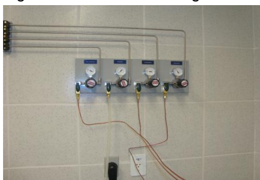
Figura 24 - Torneiras dos gases
