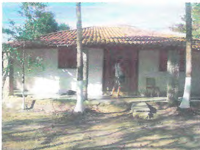
Figura 2. Casa sede da Fazenda Tarumã, Pacajus/CE.
