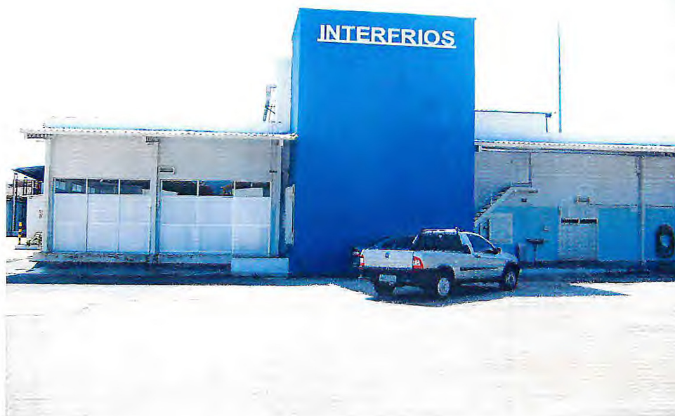
Figura 1 - Vista parcial da indústria beneficiadora de pescado INTERFERIOS – Intercâmbio de Frios S/A, em Fortaleza, Ceará.
