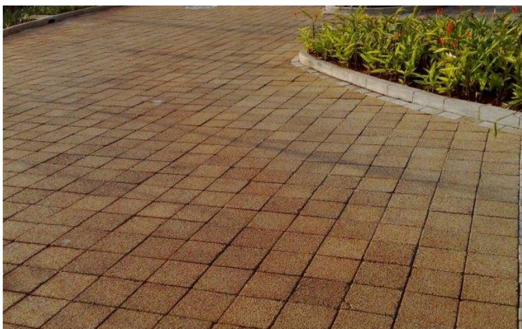
**FIGURA 39 - Piso Drenante.** Fonte: [delas.ig.com.br](http://delas.ig.com.br). Acesso: jan. 2013.
