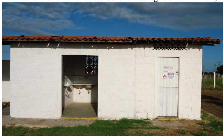
Figura 12 – Local de armazenamento de defensivos agrícolas - BASF, Jaguaruana/CE
