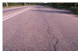
Trincas longitudinais
