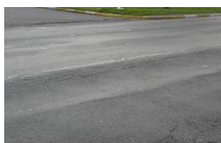
Deformação permanente
