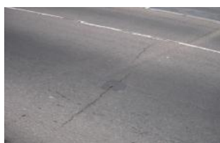
Trincas transversais
