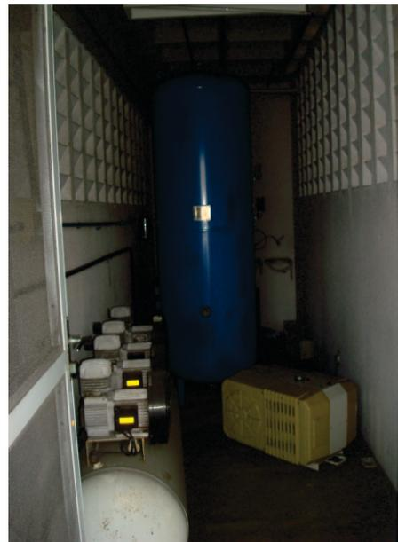
FIG. 30- COMPRESSOR DE AR ESTERILIZADO E CILINDRO DE OXIGÊNIO.
