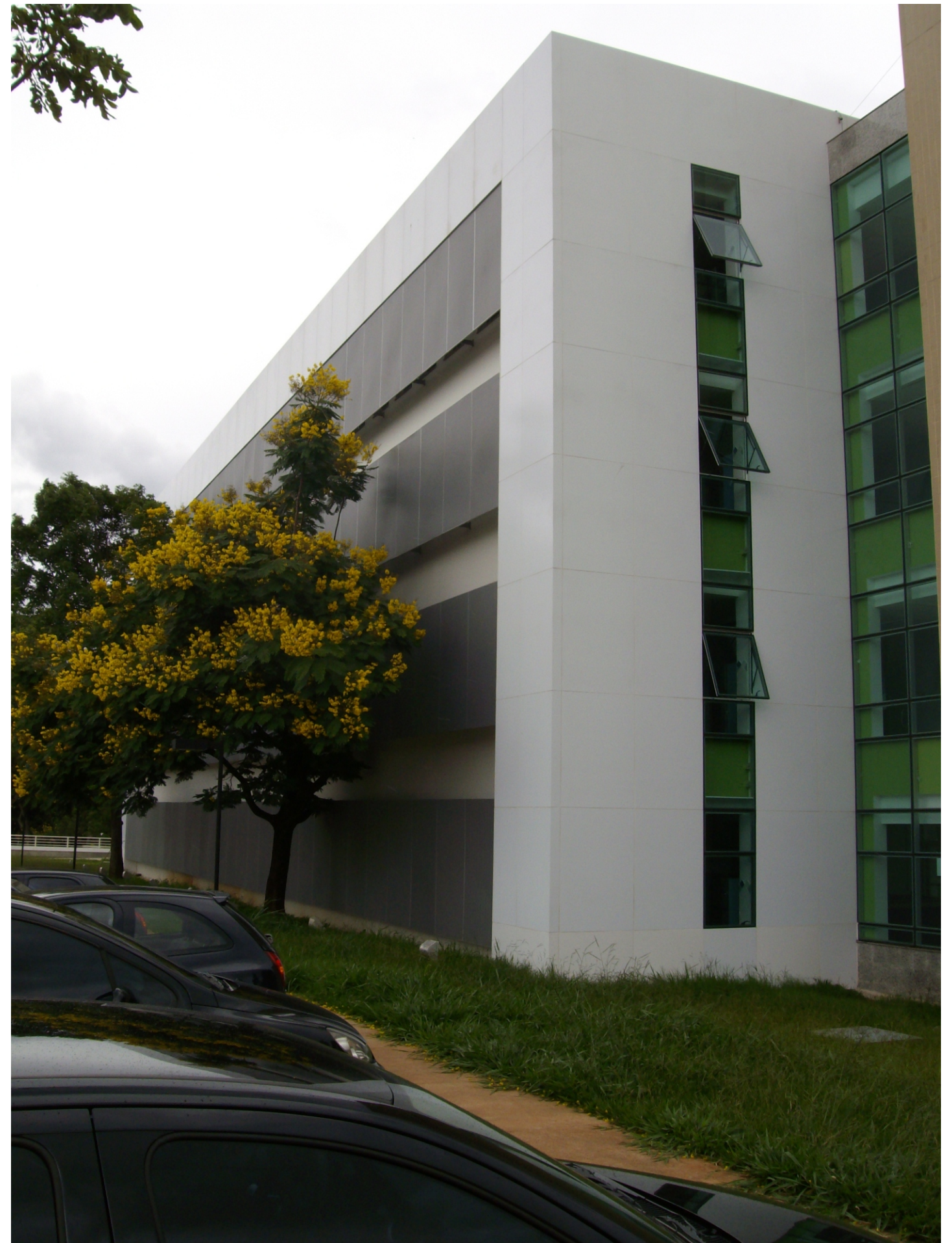
Fig. 09 - Vista do fundo do bloco administrativo. Arquivo pessoal
