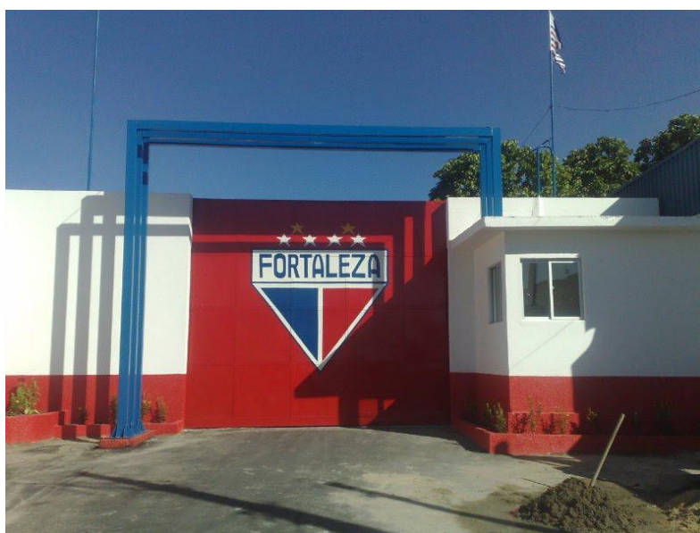
Figura 2 - Portão após a obra
