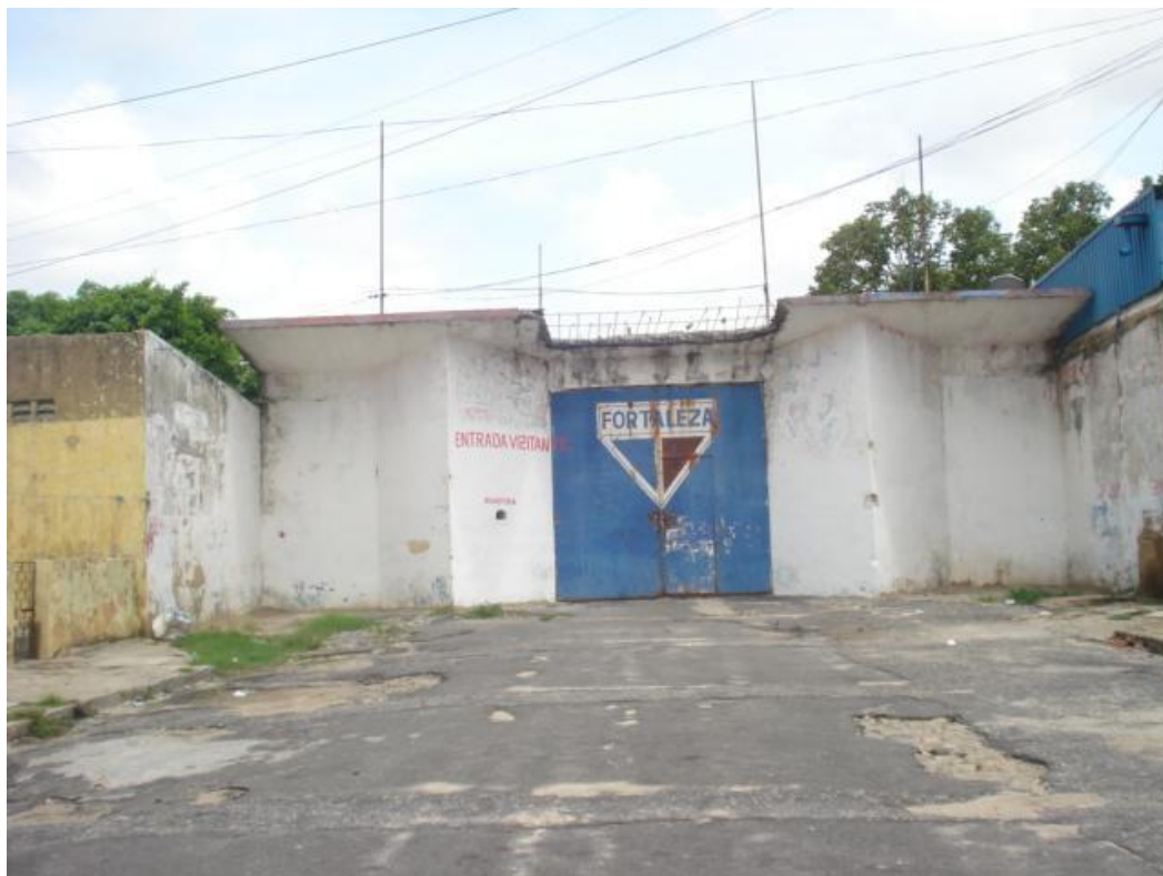
Figura 1 - Portão do Estádio Alcides Santos antes da reforma
