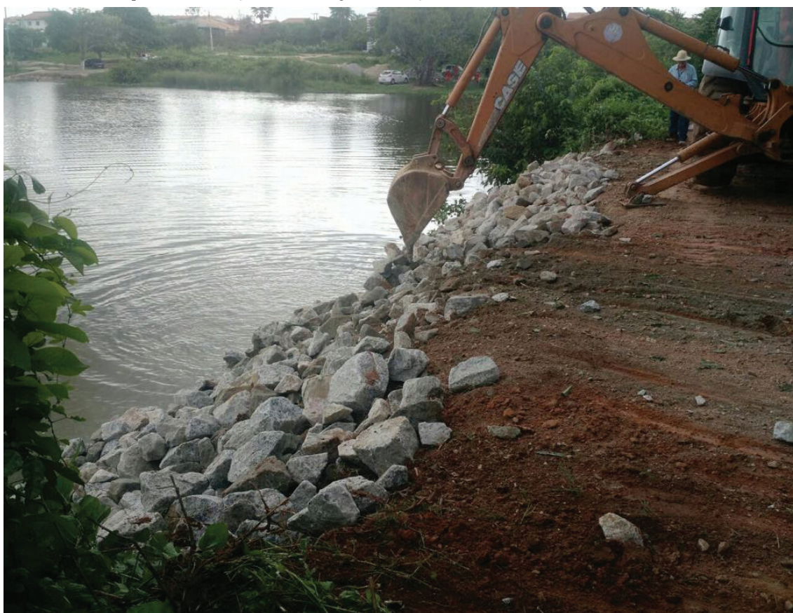
Figura 36 Obras para restauração da barragem do Açude da Viúva
