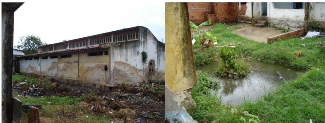
Fig.21 - IPPOO –2009 – Vista da situação de esgotamento sanitário (à esquerda) e vista do acúmulo de lixo entorno de uma edificação (à direita). 2009
