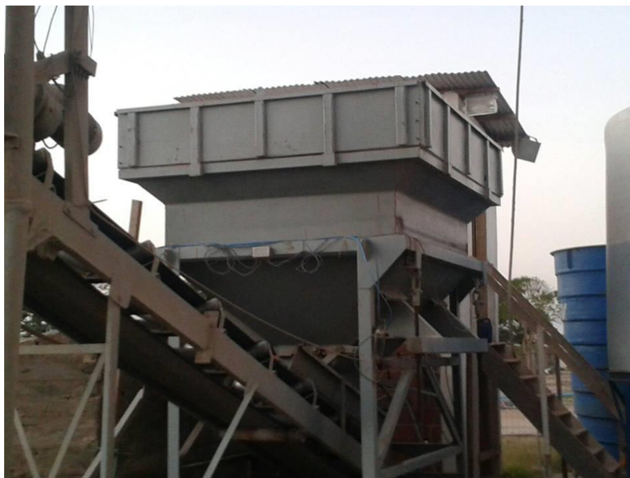
Figura 10 - Balança utilizada para dosagem do concreto
