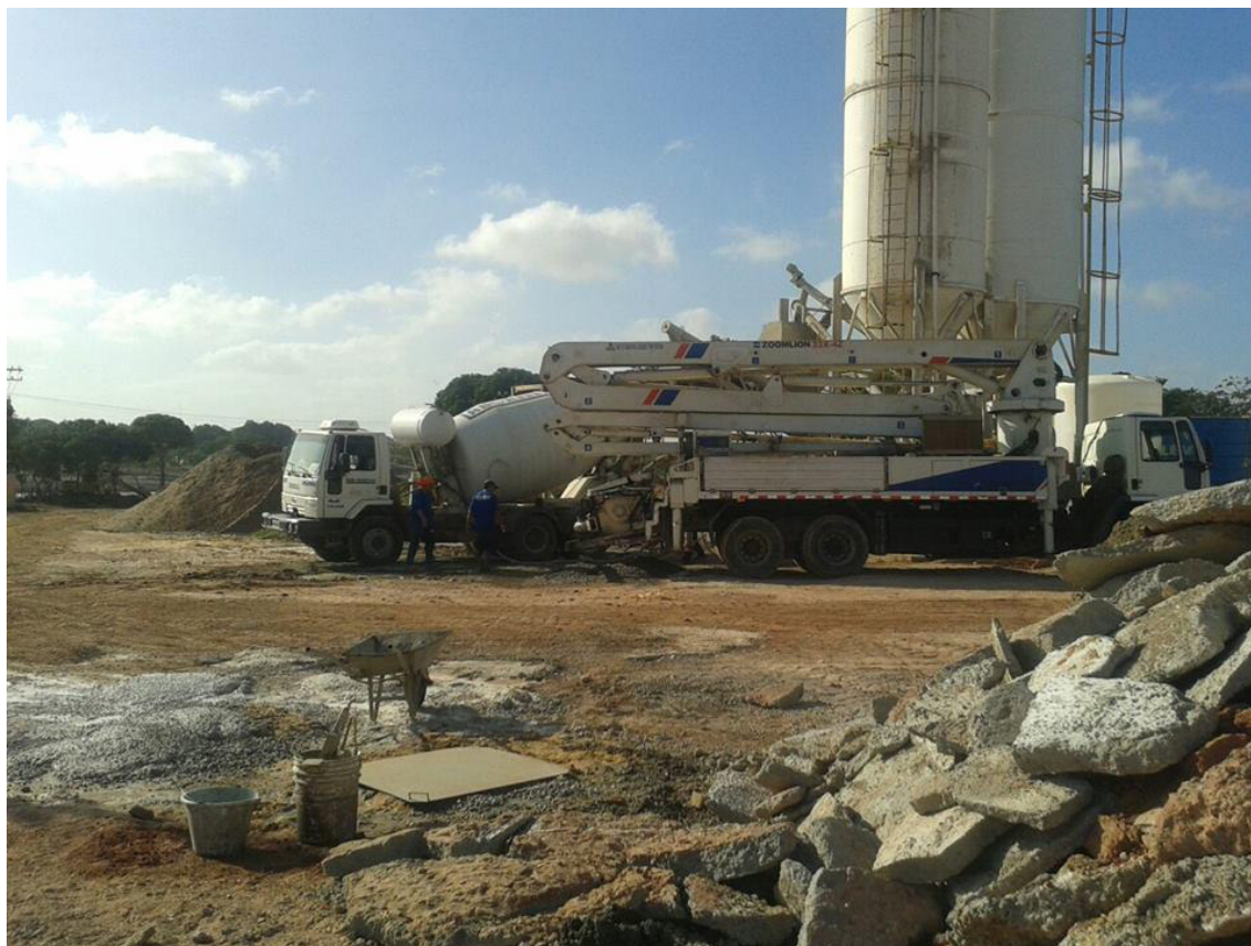
Anexo 5 - Caminhão betoneira sendo carregado
