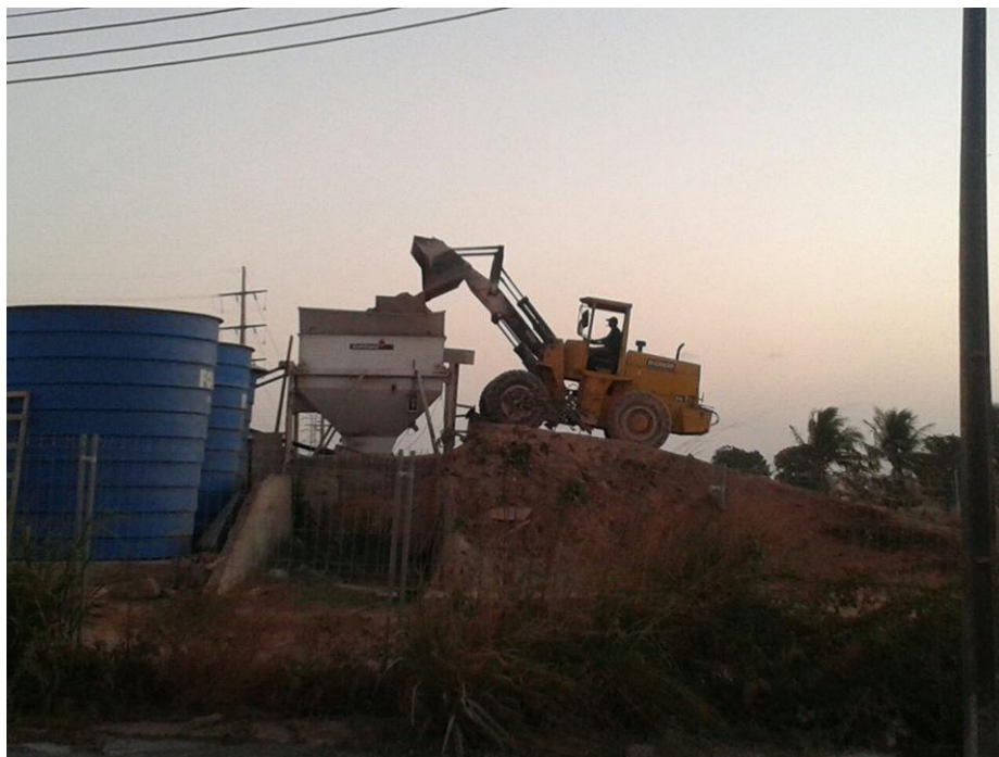
Figura 9 - Escavadeira adicionando o material à balança
