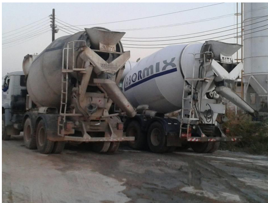
Figura 11 - Caminhão betoneira responsável pelo transporte do concreto
