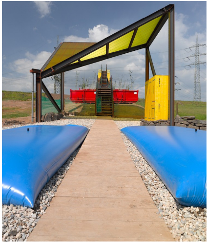
Foto da Coberta de Captação de águas Pluviais
