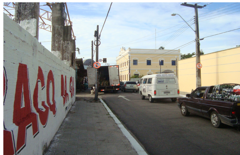
Foto Calçada e muro da Feira do Buraco - Confinamento
