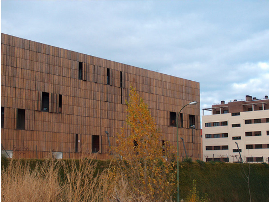
Foto da Fachada com Paíneis
