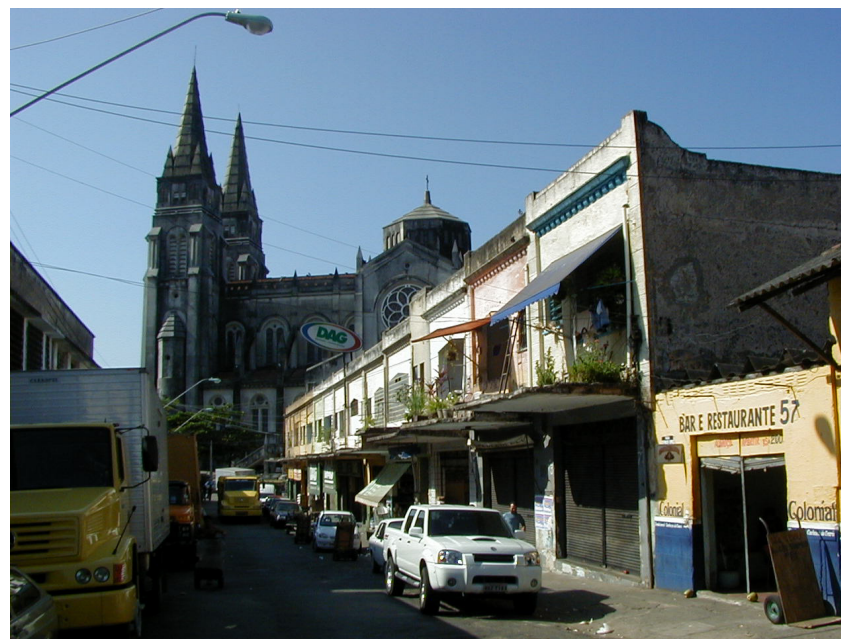
Foto do Edifício Existente a partir da r. Gov. Sampaio
