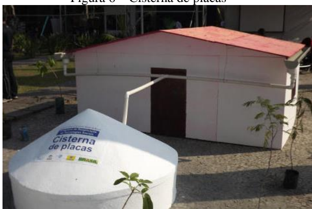
Figura 6 – Cisterna de placas
