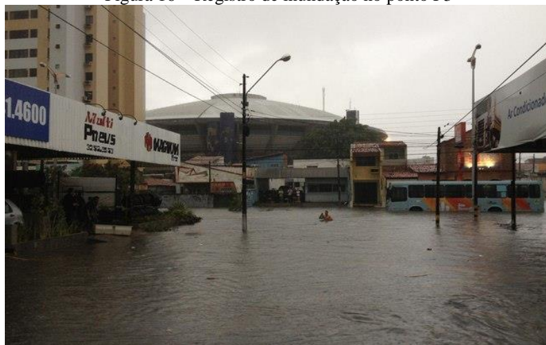
Figura 16 – Registro de inundação no ponto P3
