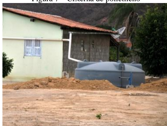
Figura 7 – Cisterna de polietileno
