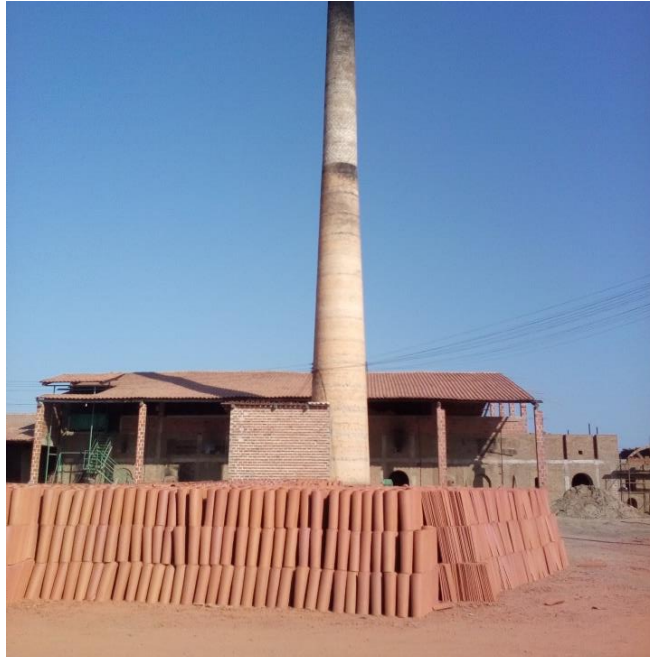
Figura 8 – Armazenamento de telhas em uma indústria de cerâmica no município de Russas, Ceará.
