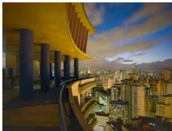
Figura 59 - Cobertura do Ed. Viadutos
