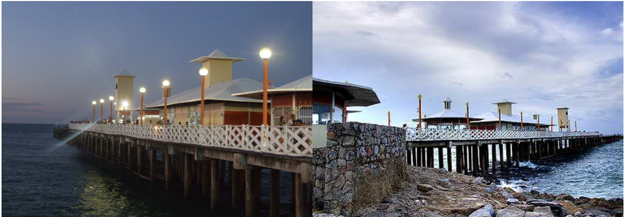
Figura 16 - Ponte dos Ingleses
