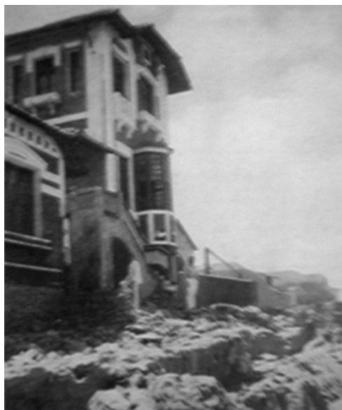
Figura 12 - Destruição das casas na praia
