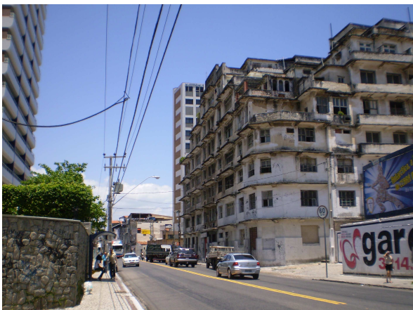
Figura 36 - O Iracema Plaza visto da Av. Historiador Raimundo Girão
