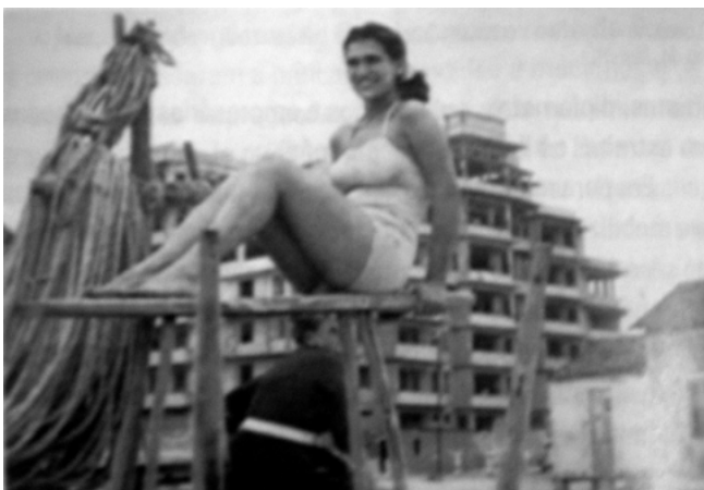
Figura 22 - Hebe Camargo e o Iracema Plaza Hotel em construção, 1950.
