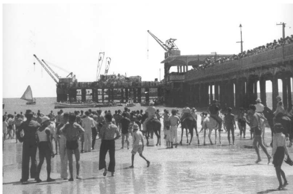
Figura 8 - Ponte Metálica em dia festivo de 1946
