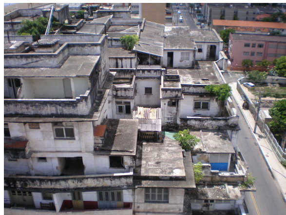
Figura 44 - Escalonamento de andares nas fachadas oeste e sul
