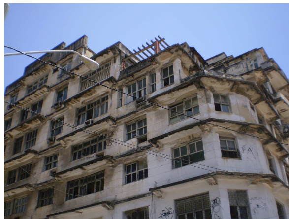
Figura 39 - Fachada sul do edifício
