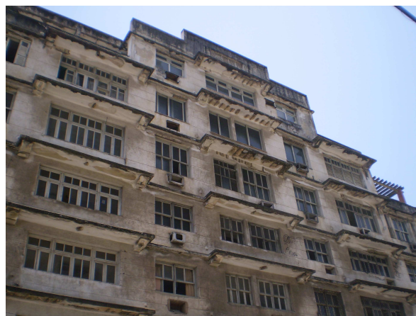
Figura 40 - Vista a aproximada da fachada sul
