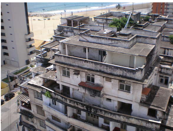
Figura 43 - Sexto, sétimo e oitavo pavimentos da fachada oeste
