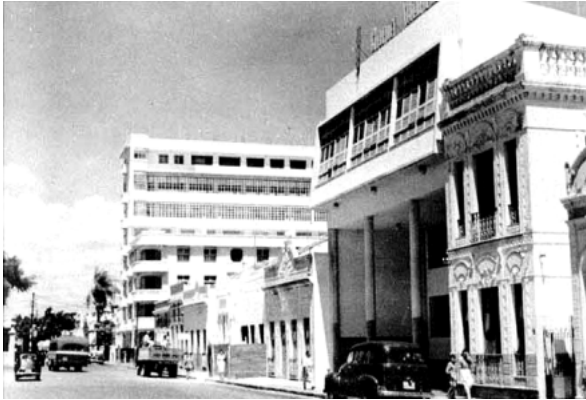
Figura 53 - Lord Hotel em construção, anos 50
