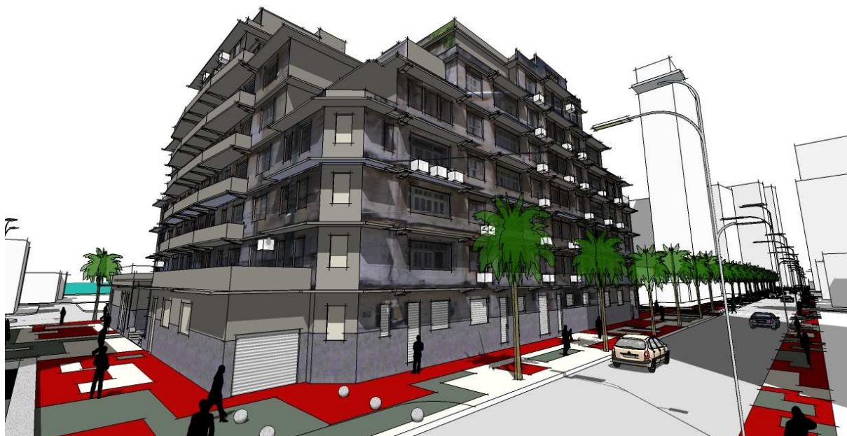
Figura 90 - Vista da fachada sul
