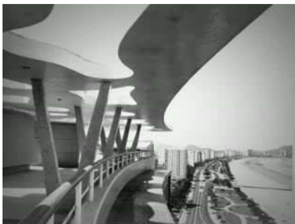
Figura 57 - Cobertura do Ed. Verde Mar
