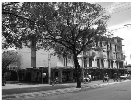
FIGURA 20 - Edifício residencial degradado
