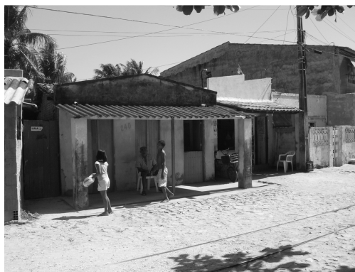
FIGURA 6 – Residências e vias de baixa qualidade na comunidade Poço da Draga
