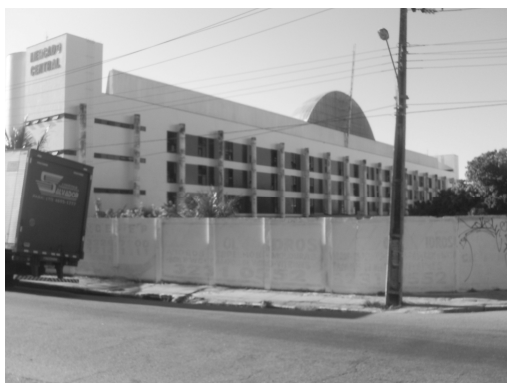
FIGURA 9 – Riacho Pajeú e área verde bloqueados por muro
