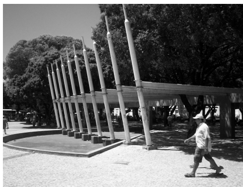
FIGURA 40 – Estrutura em péssimo estado físico
