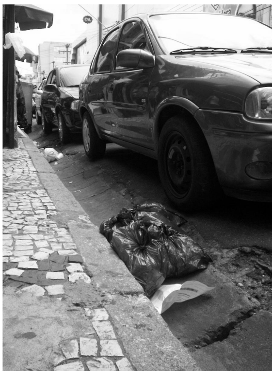
Figura 55 – Lixo acumulado em sarjeta transformada em “vale”
