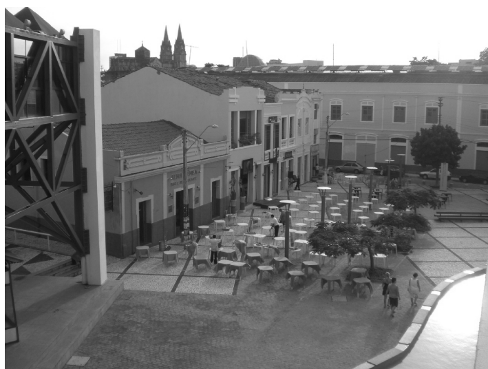
FIGURA 7 – Bares e restaurantes do Centro Dragão do Mar em antigos casarões reformados
