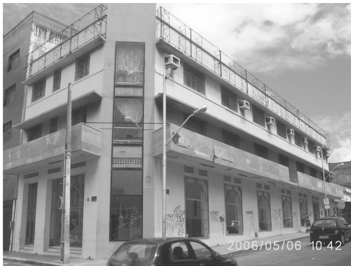
FIGURA 8 – Antigo hotel desativo nas dependências da Praça da Sé (Fonte: Escritório Piratininga)
