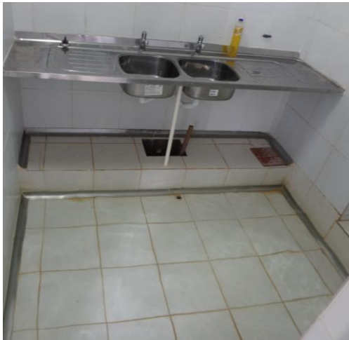
Figura 25 – Pé-de-lúvio na entrada da área limpa e pia para higienização das mãos
