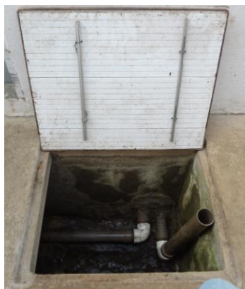
Figura 19 – Sistema de escoamento tipo cotovelo móvel
