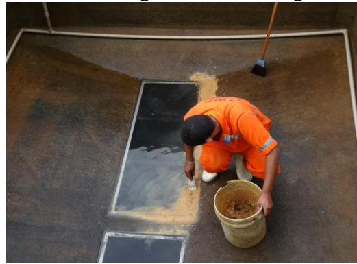
Figura 11 – Encaixe entre a moldura telada e a moega vedada com argila
