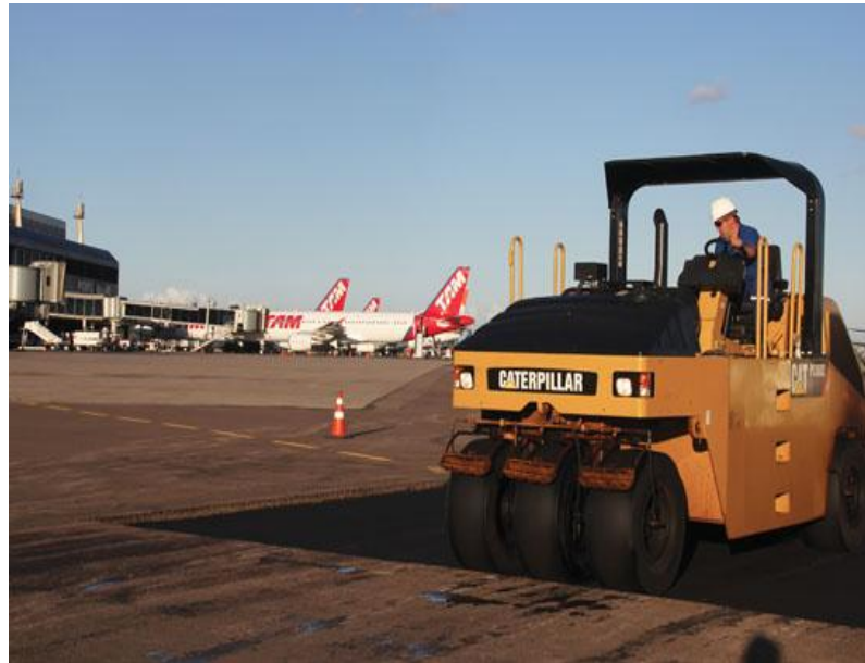
Figura 2.29: Rolo compactador pneumático. Fonte: CARTERPILLAR (2013).
